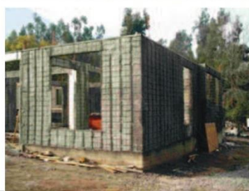
Mortero sobre la aislación
